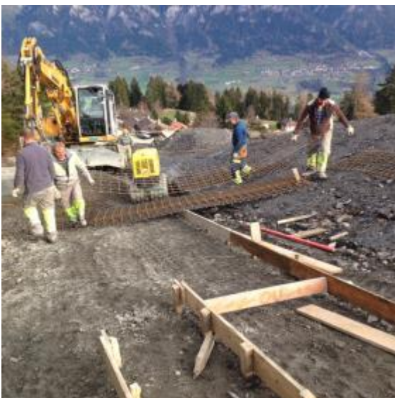
Plaatsen van de staalmatten vervalt
