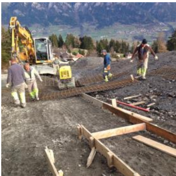
Plaatsen van de staalmatten vervalt
