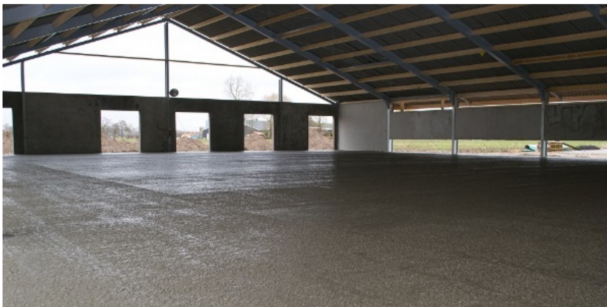
Mooi resultaat betonnen vloer met kunststofvezel. Foto: Convez
