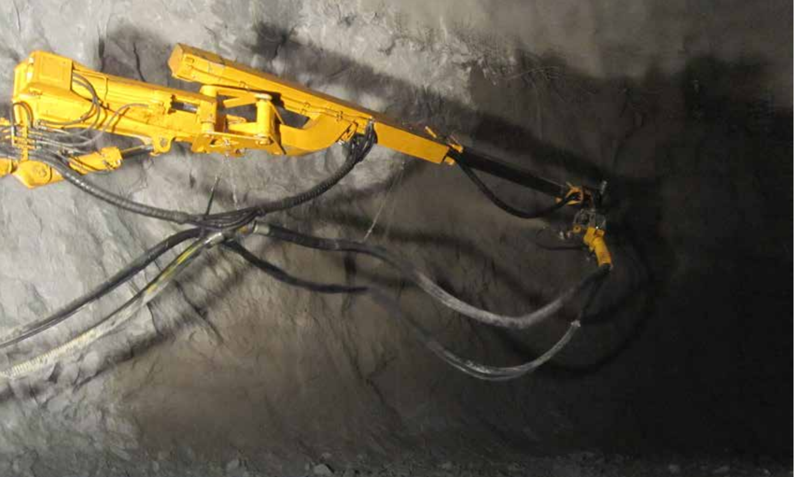
Test met spuitbeton voor een tunneltoepassing
